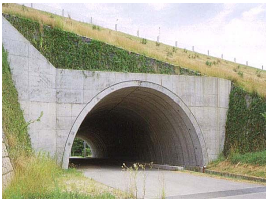
写真-1 一般的なアーチカルバート構造物
